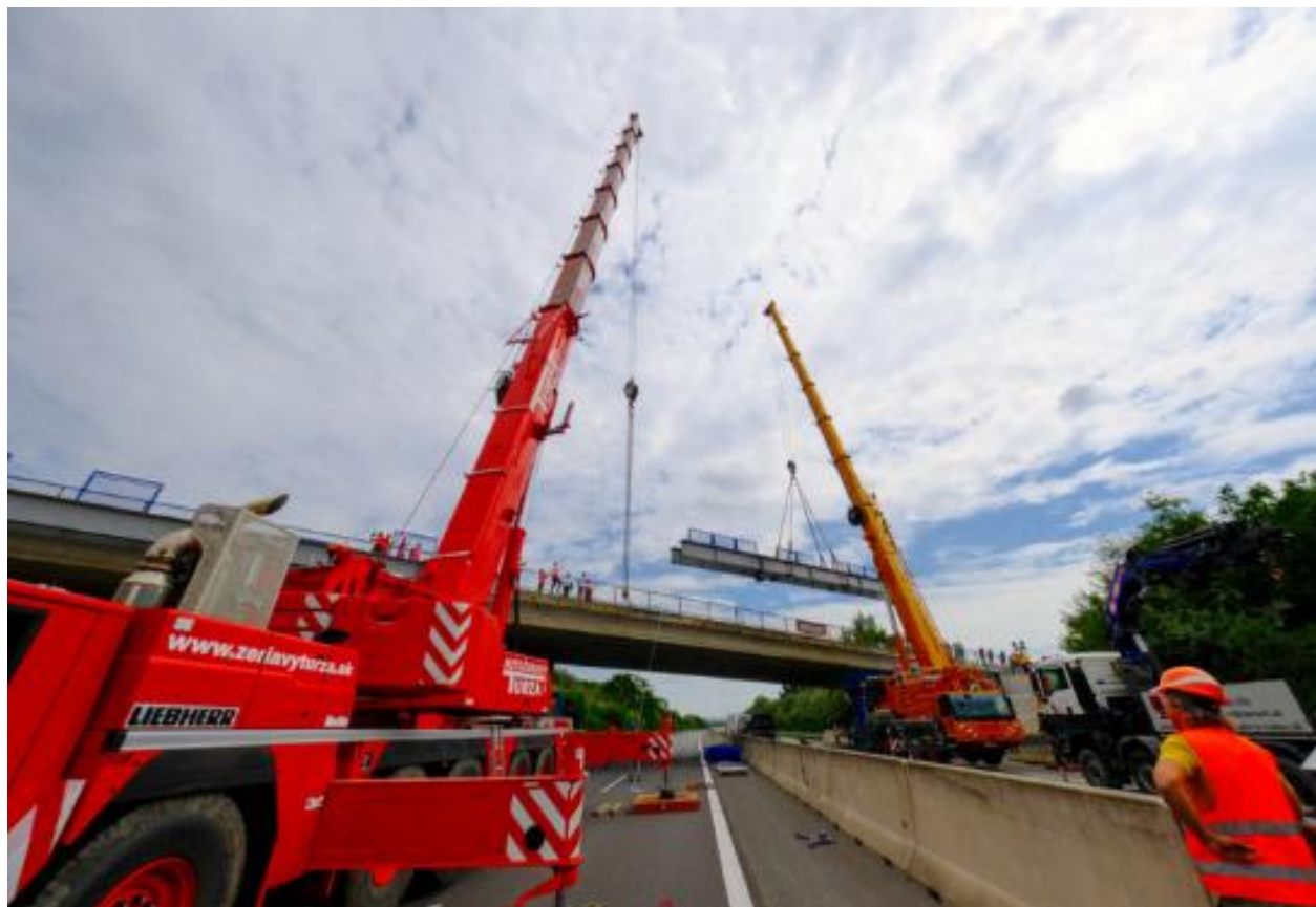
Obrázok 9 Osádzanie cyklomosta pri Zavare (12. 7. 2025). Zdroj: Dušan Vančo, Trnavské rádio
