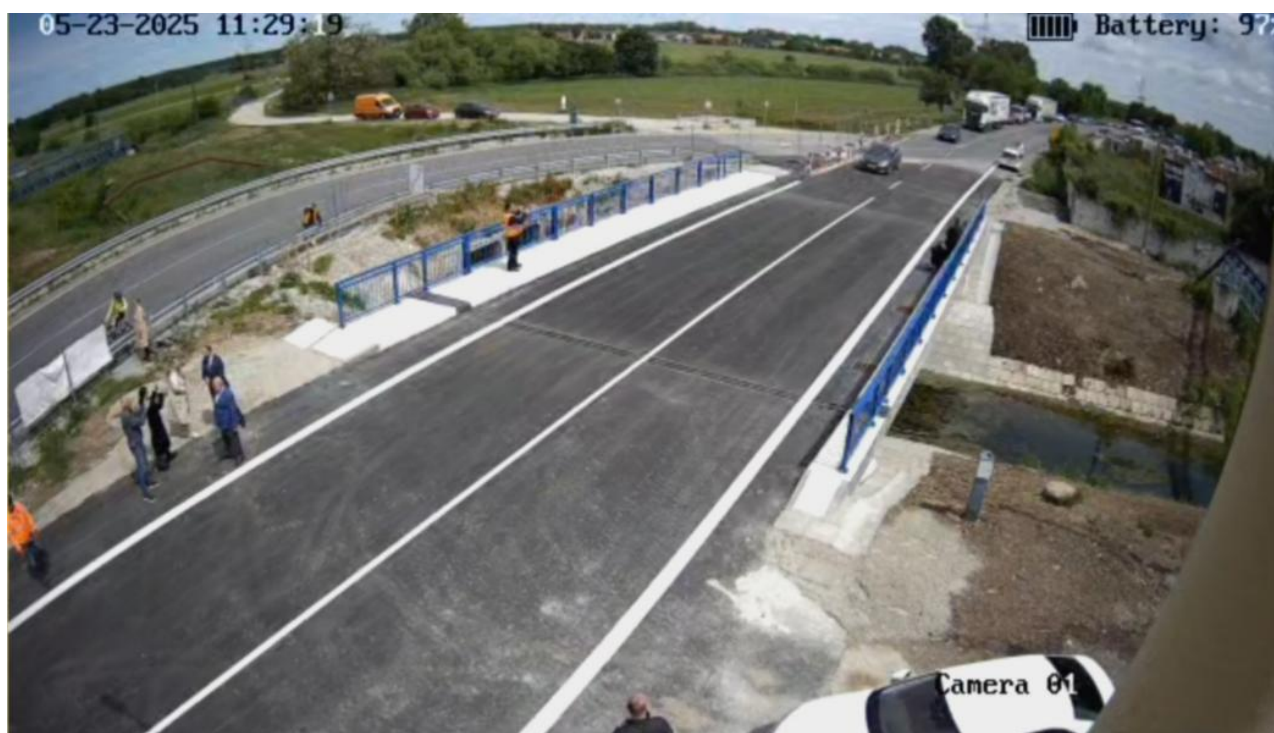
Obrázok 5 Rekonštrukcia mosta M433 cez Chvojnicu pri Holíči – pred odstránením dočasného premostenia, Zdroj: SÚC TTSK
